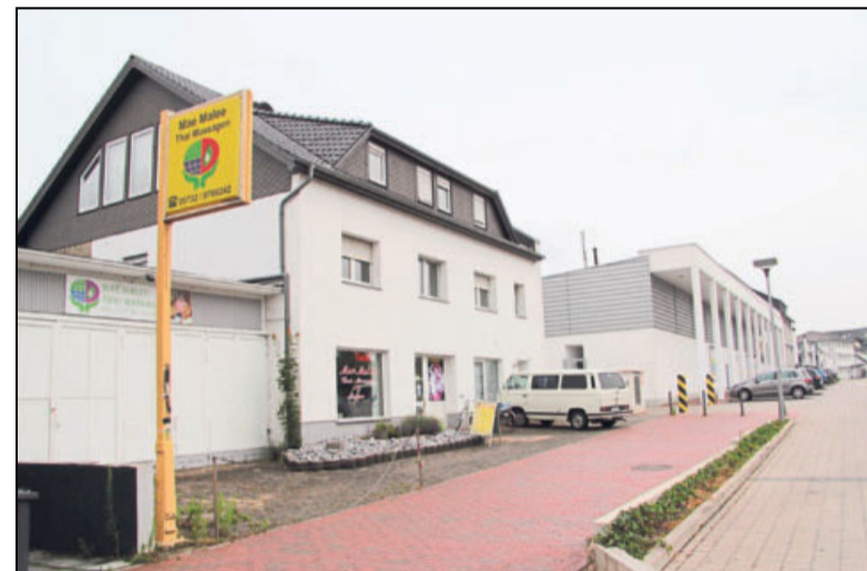
Um dieses Teilstück der Alten Bänder Straße vor dem Massagesalon ist es im Bauausschuss gegangen.
